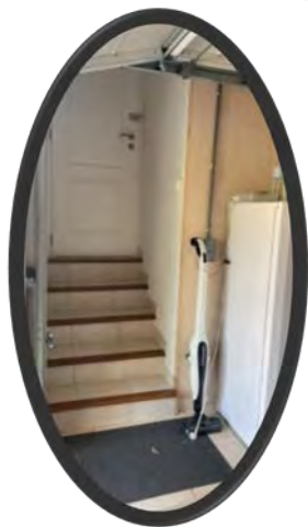
Escalier intérieur du garage
